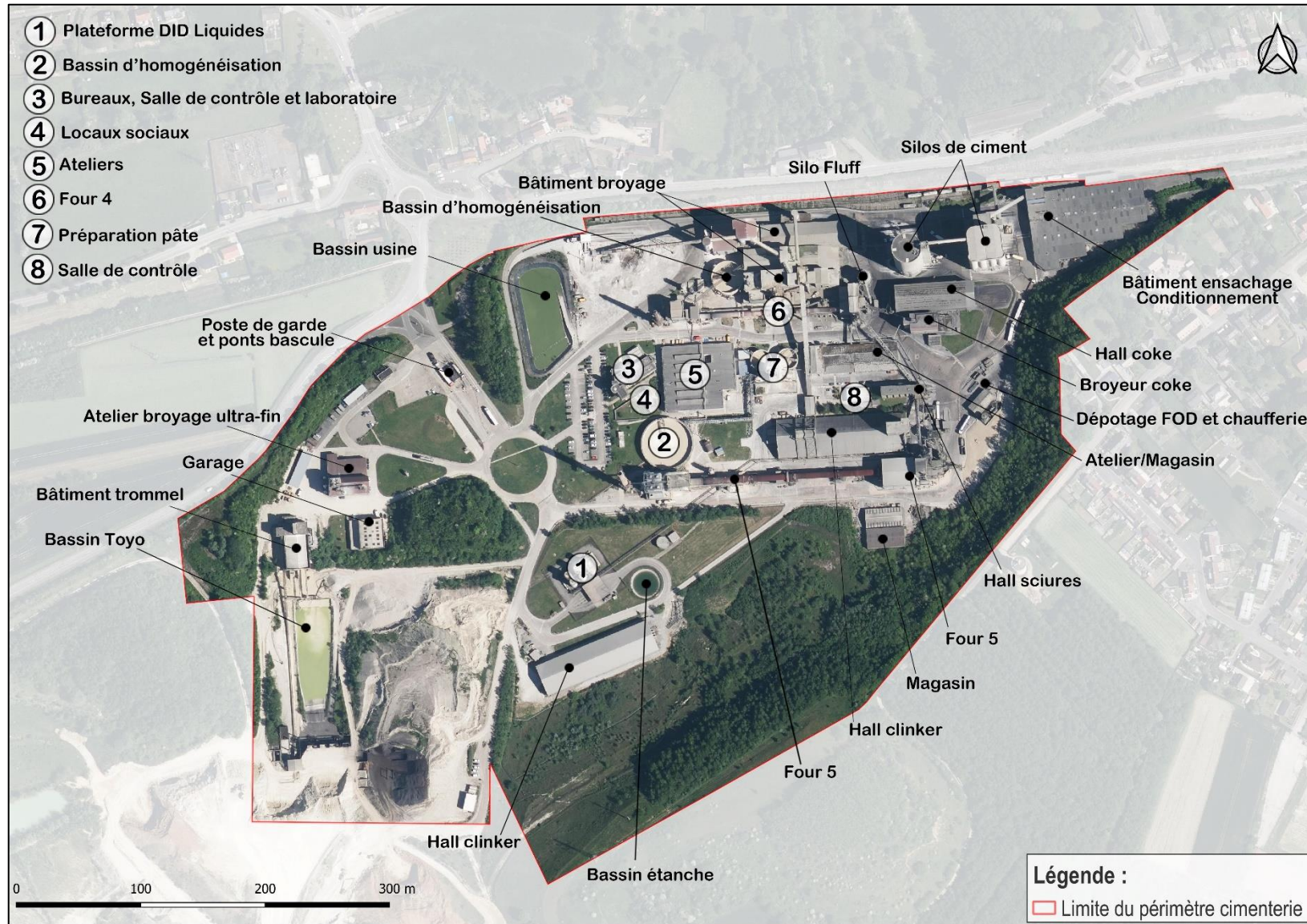
Figure 3 : Vue aérienne de l'établissement EQIOM à Lumbres et localisation des principales installations dans sa configuration actuelle
